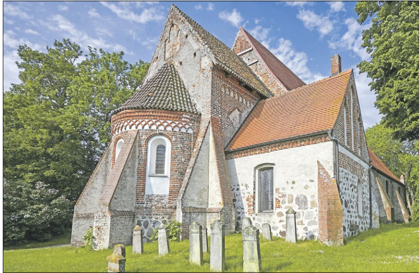
▲ Die pittoreske Dorfkirche in Altenkirchen ist die älteste Dorfkirche Rügens. Durch ihr Dach dringt Feuchtigkeit ein und der Ostgiebel muss dringend instandgesetzt werden. Foto: Deutsche Stiftung Denkmalschutz
