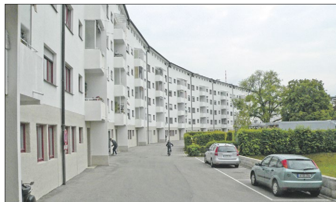
◀ Der Schubert-Hof in Augsburg wurde nach Plänen von Wechs errichtet.
