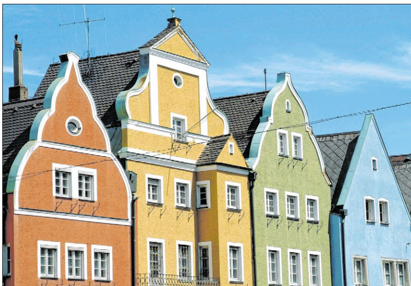
▲ Der Wandel vollzog sich, ohne groß Schlagzeilen zu machen: Der Landstrich zwischen Tirschenreuth, Neustadt an der Waldnaab (im Bild) und Weiden, über Jahrzehnte geprägt durch die Randlage am Eisernen Vorhang, durch Rekord-Arbeitslosenzahlen und wirtschaftlichen Stillstand, ist Bayerns neue Vorzeigeregion. Foto: obx-news
