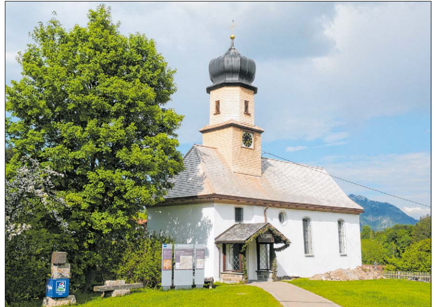
▲ Die Nikolauskapelle auf dem Kappelbichl ist nach der Sanierung wieder ein Schmuckstück. Foto: Gutsmiendl
