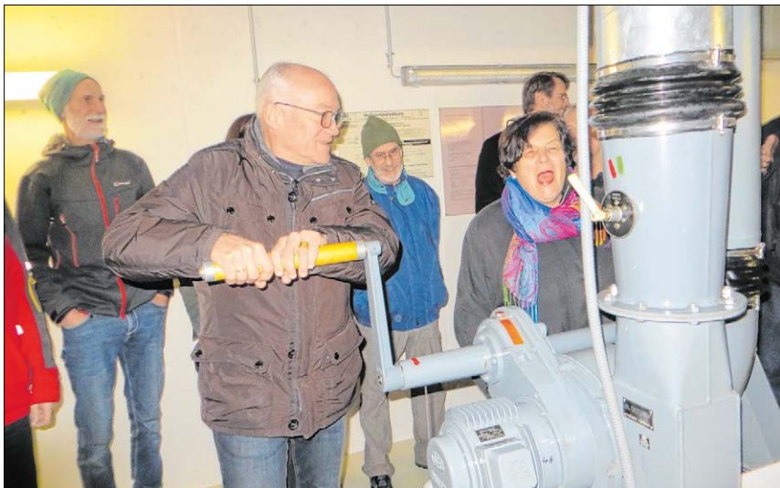
▲ Mit der Kurbel konnte bei Versagen der automatischen Belüftung manuell Frischluft zugeführt werden. Foto: Klimm
