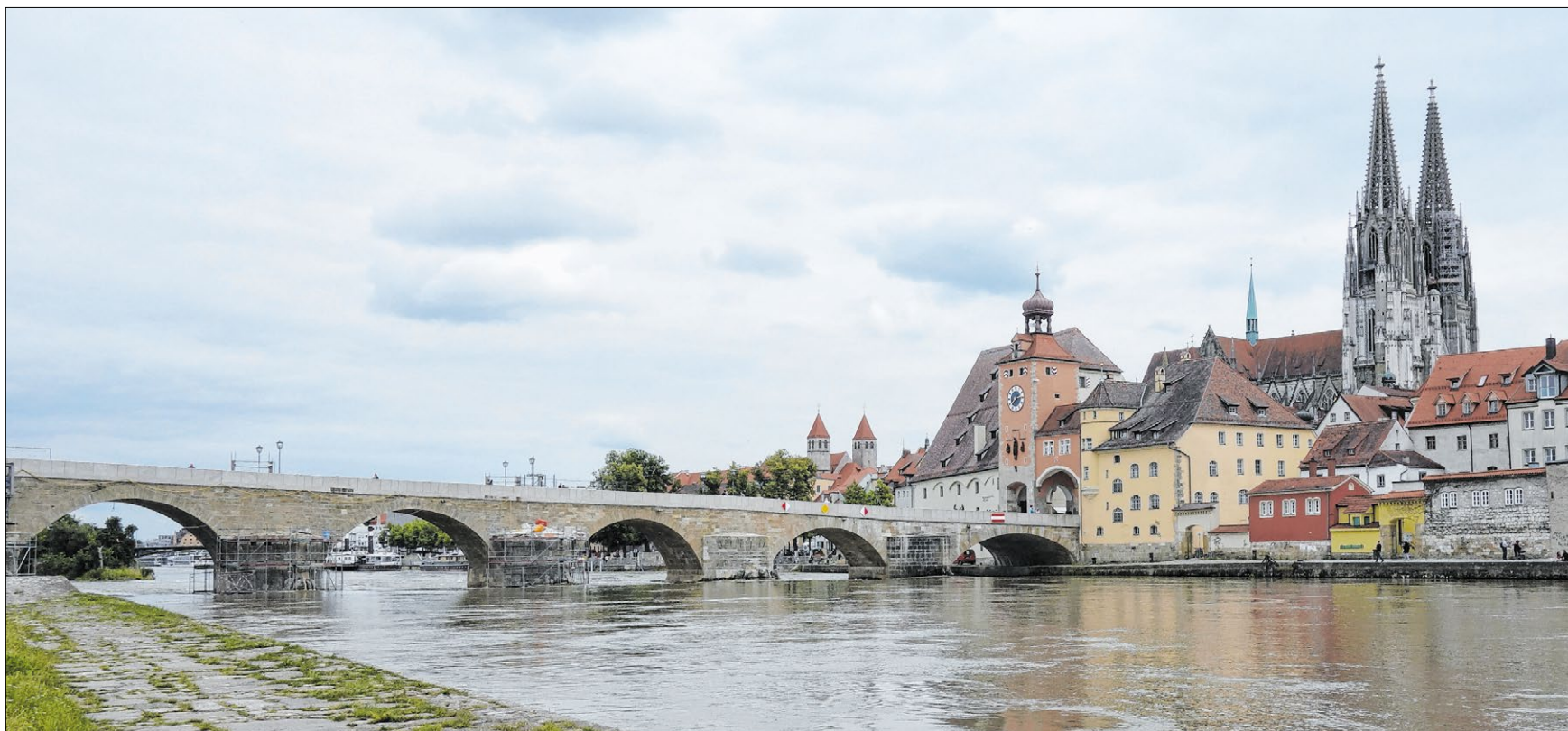
▲ Das mittelalterliche architektonische Meisterwerk der „Steinernen Brücke“, Wahrzeichen der Stadt Regensburg, wurde in neun Jahren umfassend saniert. Foto: Mohr
