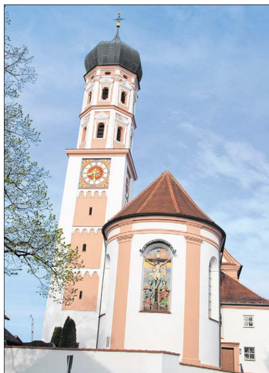
◀ Die Kirche St. Michael erhielt einen neuen Außenanstrich in Weiß und Rosé.
