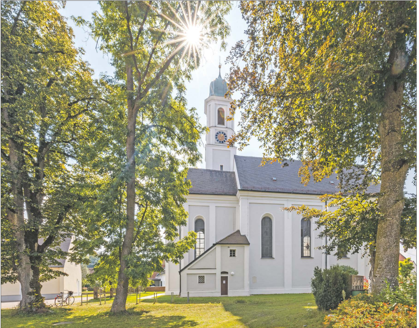
▲ Die Pfarrkirche St. Peter und Paul in Affing wurde am ersten Sonntag im Oktober 1689 geweiht, wie man am Weihedatum an der Westfassade ablesen kann. Das vierachsige, pilastergegliederte Langhaus mit Stichkappentonne verfügt über einen quadratischen Turm mit kurzem Oktogon und glockenförmiger Haube. Foto: Banner
