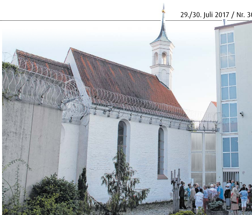
▲ Mit Stacheldraht bewehrt: Die über 700 Jahre alte Severinskapelle liegt im Gefängnis der ehemaligen JVA Augsburg und ist nur über die Anstalt zugänglich.
