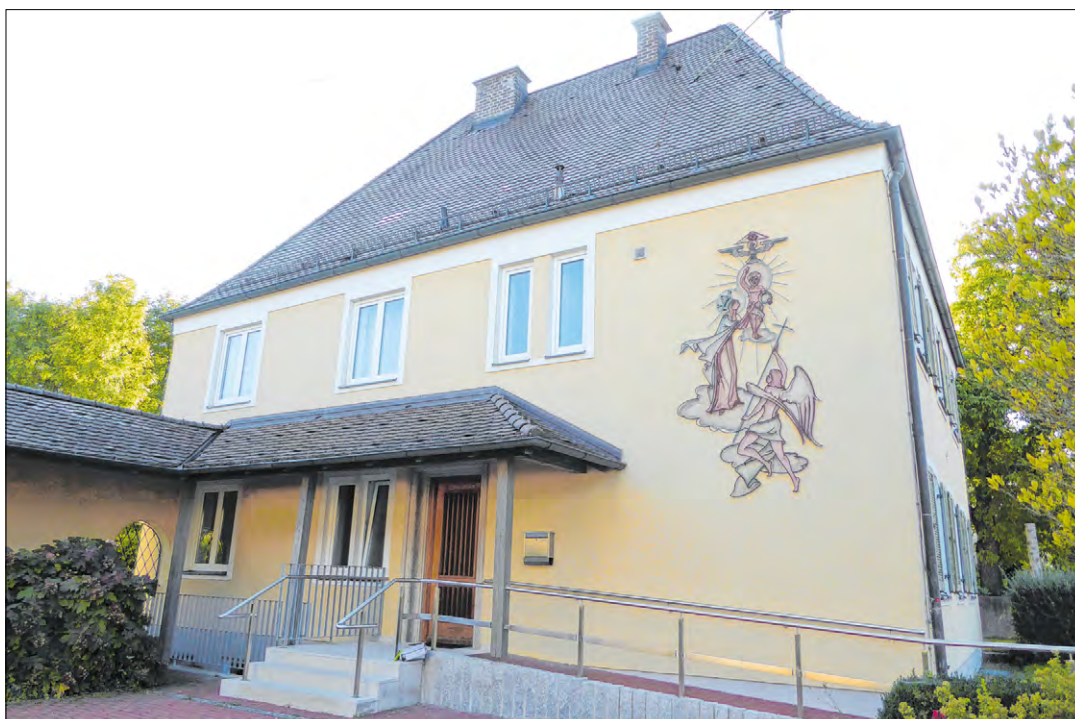
◀ Beim Umbau des Pfarrhauses wurde darauf geachtet, dass auch Behinderte das Verwaltungszentrum der Pfarreiengemeinschaft besuchen können.
