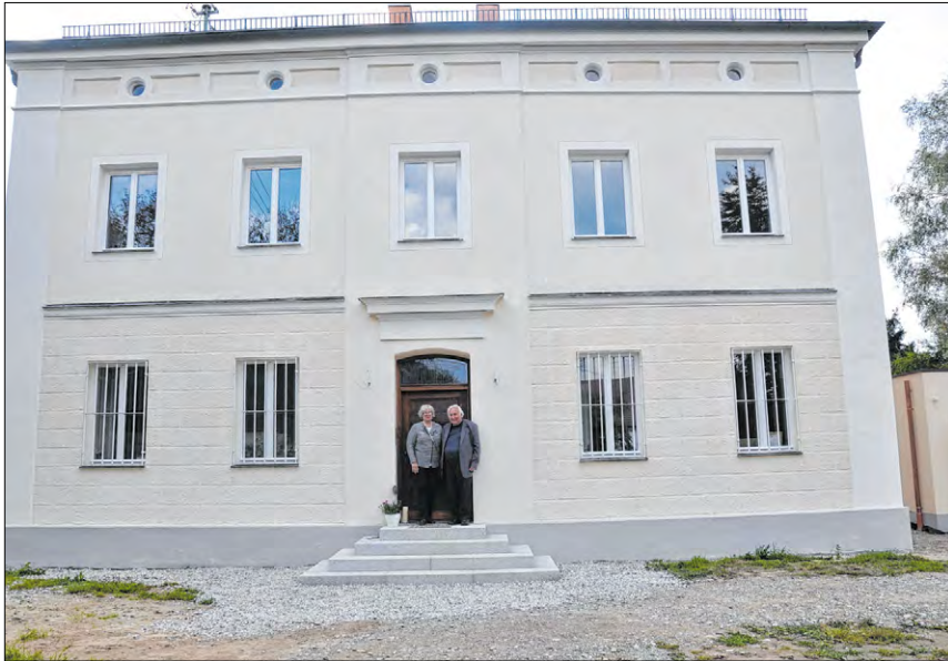
▲ Pfarrer Johannes Kuen und Gabriele Symann haben das Pfarrhaus in Oberwiesenbach gekauft und renoviert. Foto: Geißler
