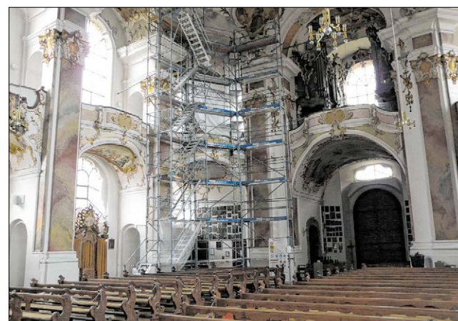
◀ An einem Teilbereich der Kirche wird innen und außen eine „Musterachse“ erstellt. Sie hilft, Kosten und Umfang der notwendigen Renovierungsarbeiten zu ermitteln.
