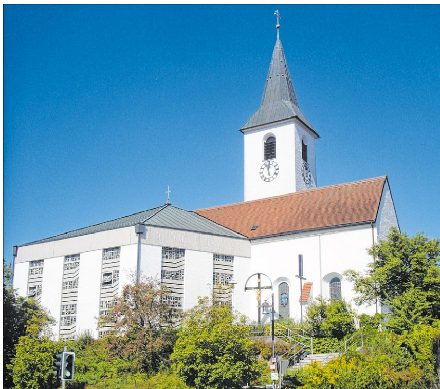
▲ Bei der Kirche St. Martin in Gebenbach wurde das ehemalige, 1690 errichtete Langhaus zwischen 1975 und 1976 von Fritz Schwertle aus Regensburg durch einen Sechseckbau mit durchgehenden Betonfenstern ersetzt. Foto: Mohr
