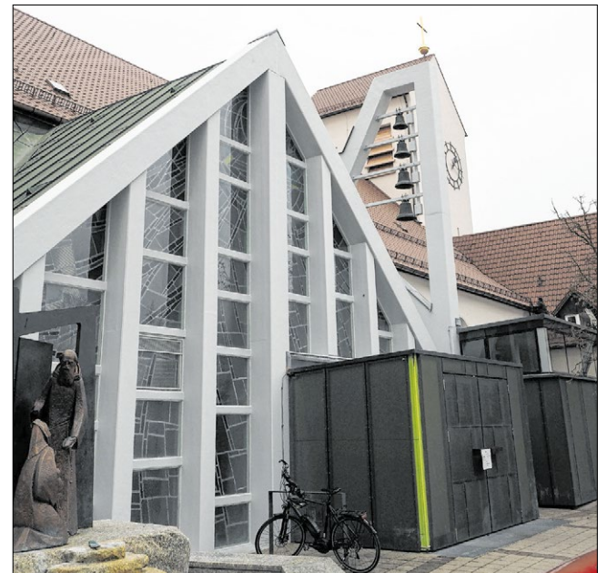
Die Pfarrkirche St. Konrad ist außen rundum saniert und erneuert worden.
