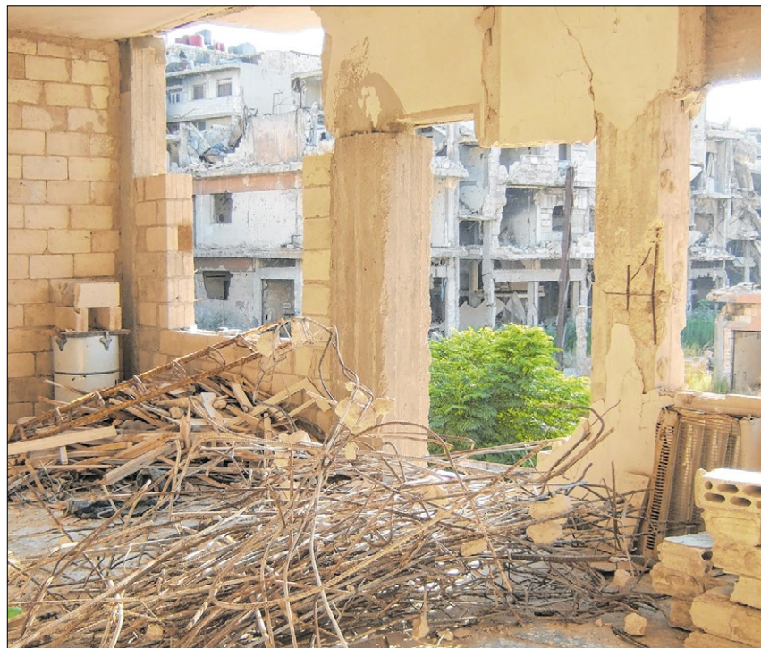
▲ Das Wohnzimmer in Amar Zeins Haus gleicht immer noch einem Trümmerfeld.
