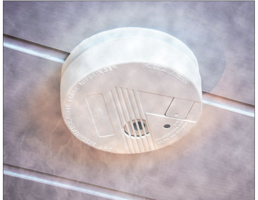
▲ Rauchwarnmelder in Neubauten sind bereits Pflicht, in vielen Bundesländern auch in Altbauten. In den meisten Fällen lassen sie sich einfach an der Decke anbringen – mit etwas Abstand zur Wand. Foto: Bernd Kasper/pixelio.de
