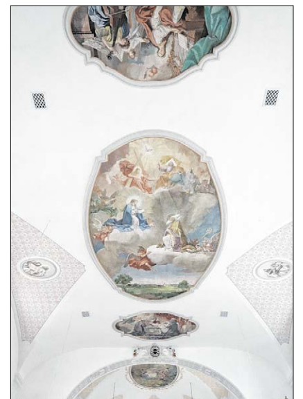
▲ Die Decke wurde gesichert, der Innenraum gereinigt.
