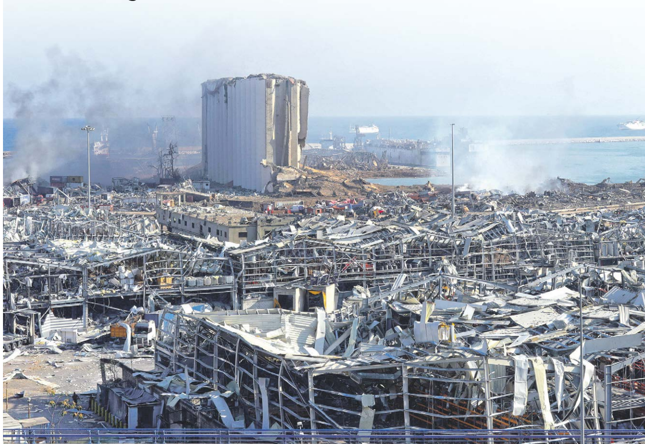
▲ Die Explosionen, die sich am 4. August 2020 um 18.08 Uhr ereigneten, verwandelten Teile des Beiruter Hafens in eine Kraterlandschaft und viele Gebäude in Ruinen. Auch weiter entfernte Häuser und Wohnungen wurden massiv zerstört. Mehr als 200 Menschen starben, über 6500 wurden verletzt, Zigtausende verloren ihre Wohnung. Foto: imago images/UPI
