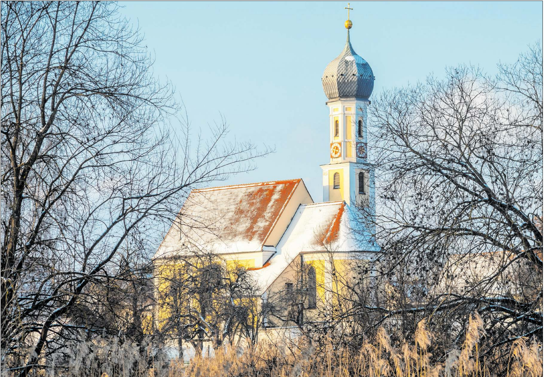
▲ Die Pfarrkirche Mariä Verkündigung im Dasinger Ortsteil Taiting wurde um 1712 neu erbaut, da der Vorgängerbau im Spanischen Erbfolgekrieg stark beschädigt worden war. Der untere Teil des Turms stammt noch von der Vorgängerkirche. Darauf wurde ein Oktogon mit Zwiebelhaube aufgesetzt. In der Weihnachtszeit lockt die große, detailreiche Weihnachtskrippe normalerweise zahlreiche Besucher in die Kirche. In diesem Jahr fällt die Krippe wegen der Corona-Pandemie allerdings deutlich kleiner aus, damit den Kirchenbesuchern mehr Platz zur Verfügung steht. Foto: Banner
