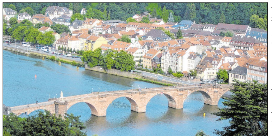
▲ Die Alte Brücke zählt zu den bekanntesten Sehenswürdigkeiten und Wahrzeichen Heidelbergs. Im Zweiten Weltkrieg wurden der fünfte und sechste Pfeiler gesprengt. Der Wiederaufbau war bereits im Juli 1947 abgeschlossen.
