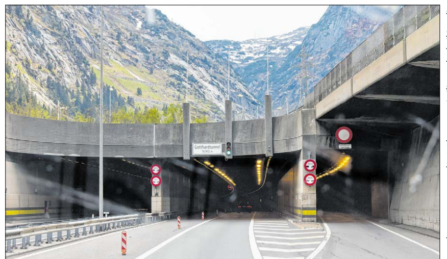
▲ Das Nordportal des Gotthardtunnels bei Göschenen. Seit seiner Eröffnung 1980 rollen täglich mehr als 20 000 Fahrzeuge durch die Röhre.
