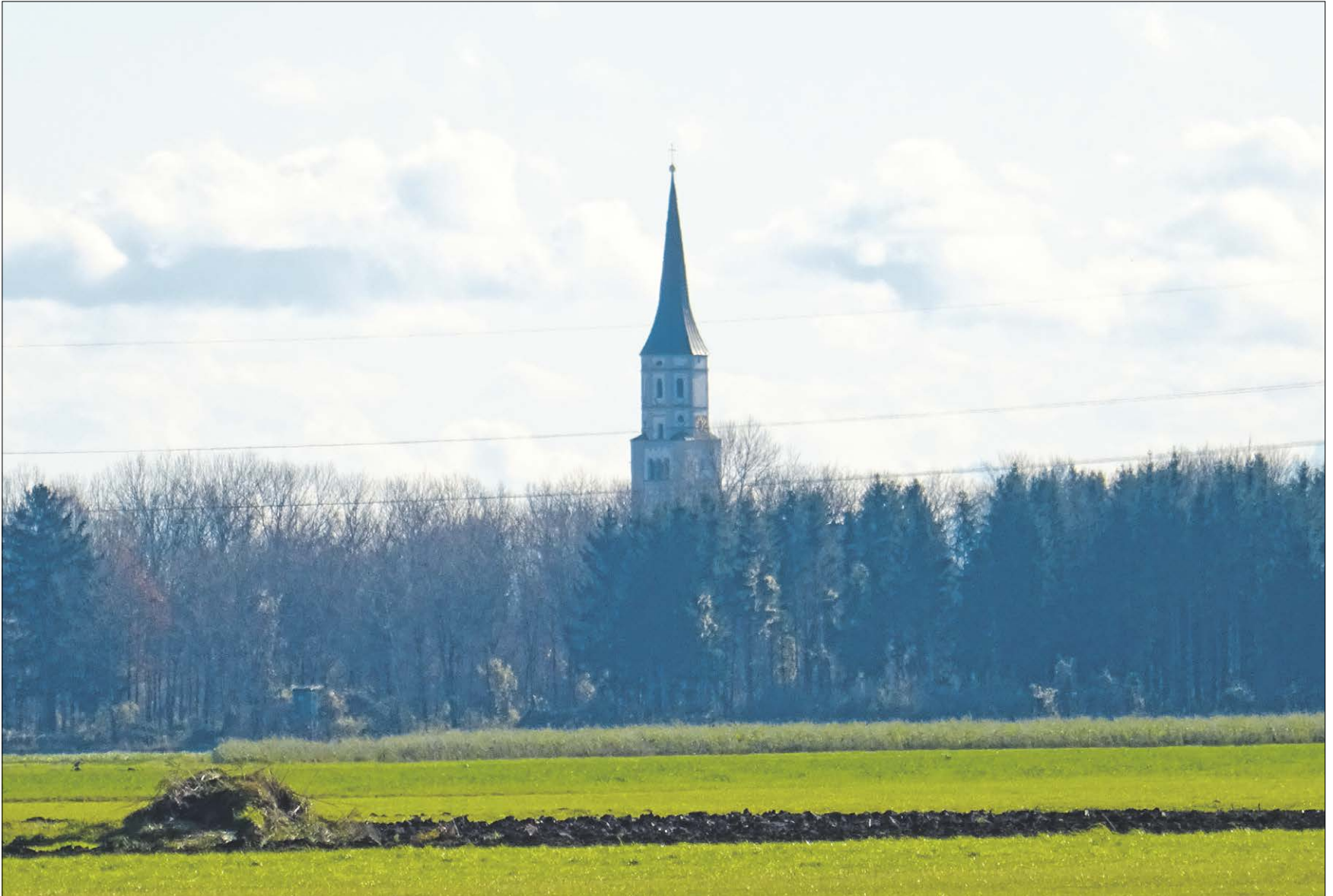
▲ Der mächtige, freistehende Turm der Pfarrkirche St. Sylvester in Hiltenfingen erhebt sich im Norden des Gotteshauses. Die fünf unteren Geschosse des Turms entstanden um 1200, die mittleren um 1490. Den quadratischen Teil schmücken Bogen- und Sägezahnfriese. 1710 wurde das Turmoktagon gebaut. Der spitze Turmhelm wurde erst 1846/50 aufgesetzt. 1788/89 ist der eingezogene, dreiseitige Chor errichtet worden. Er ist außen mit Pilastern gegliedert. Foto: Krünes
