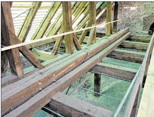
▲ Subsidiärtragwerk aus filigranen Stahlstäben in der Regensburger Ulrichskirche. Foto: Kugler + Kerschbaum
