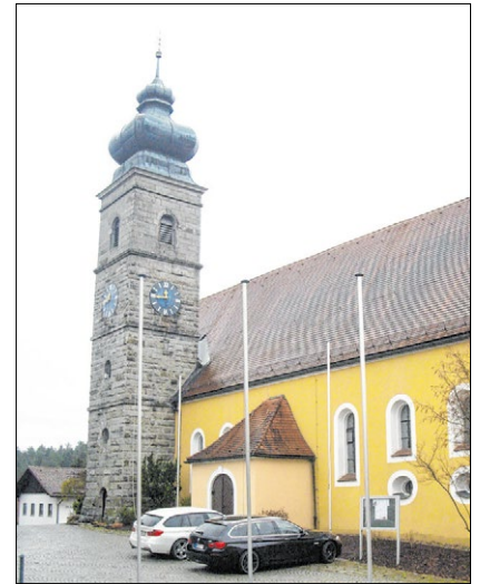
▲ Außenansicht der Kirche St. Martin in Patersdorf. Foto: Mohr
