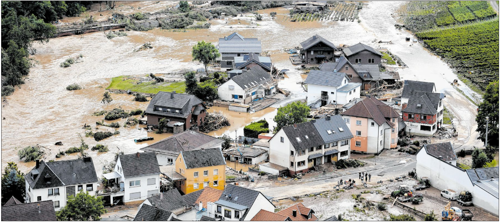
▲ Im Ahrtal trat der Fluss vielerorts über die Ufer und überschwemmte vorige Woche nicht nur Keller, sondern ganze Ortschaften. Im Bild: Marienthal, ein Dorf an der Bundesstraße 267 westlich von Ahrweiler, die von den Fluten auf einem Abschnitt einfach mitgerissen wurde. Foto: Imago/Future Image
