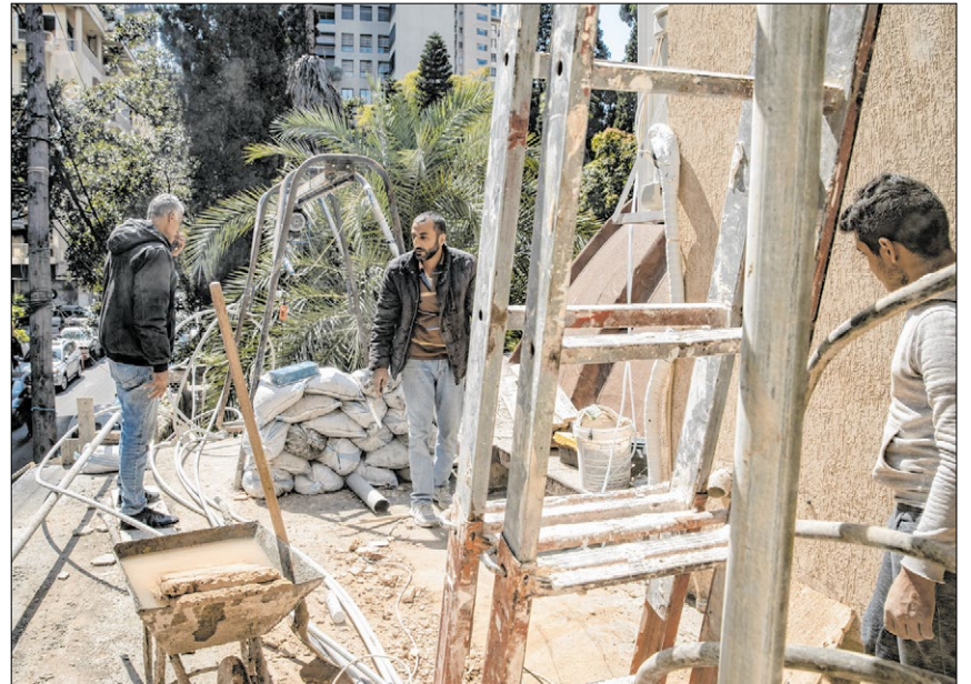
▲ Arbeiter bessern Schäden an der Beirut-er Jesuitenkirche St. Joseph aus. Ein Jahr nach der Explosion können wieder Gottesdienste gefeiert werden. Foto: KNA
