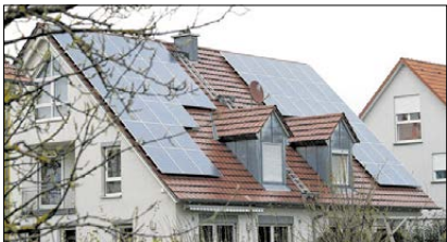
▲ Ein Solardach auf dem Eigenheim trägt zum Klimaschutz bei.
