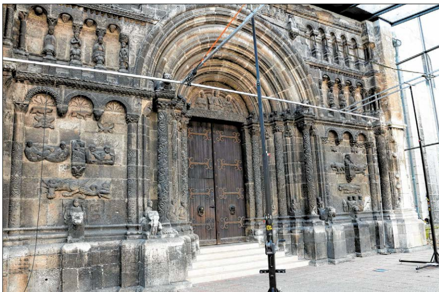
▲ Über eine Konstruktion in der Vorhalle zum Schottenportal wurde jetzt ein Netz von Sensoren gespannt. Foto: Schötz
