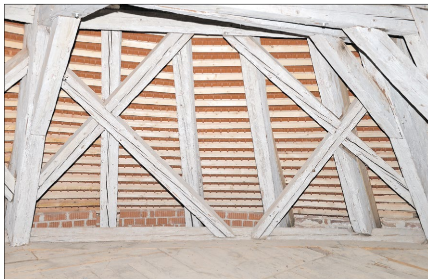
▲ Ein Blick in den renovierten ältesten Teil des barocken Dachstuhles im Chorgewölbe der Kirche. Foto: Hilmer
