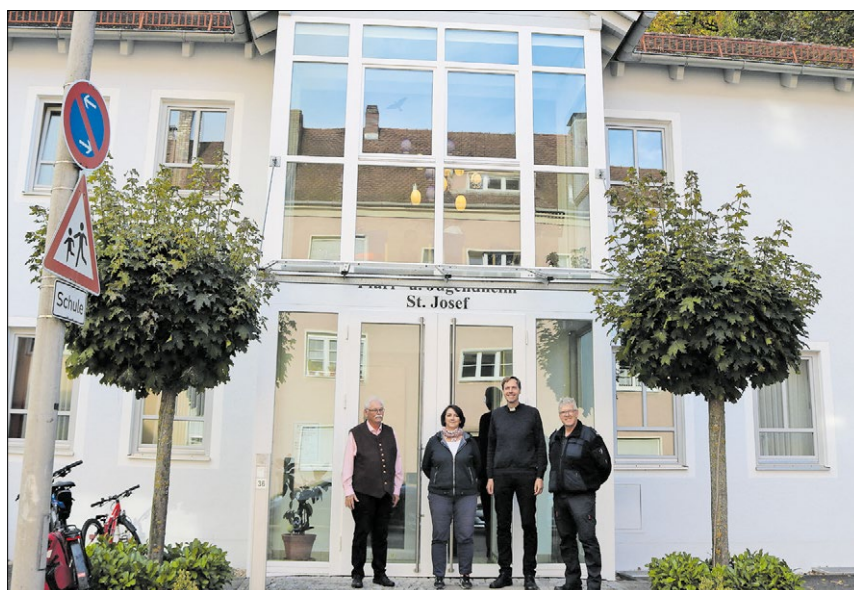
▲ Pfarrgemeinderatssprecher Reinhard Englberger, Pfarrer Martin Nissel, Architektin Anita Mühlbauer und Kirchenpfleger Anton Kirnberger (von rechts) sind mit der abgeschlossenen Renovierung sehr zufrieden. Foto: Wimmer
