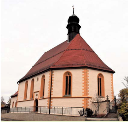
Große Freude herrscht über die nun abgeschlossene Sanierung der Friedhofskirche St. Maria Magdalena in Kemnath.
