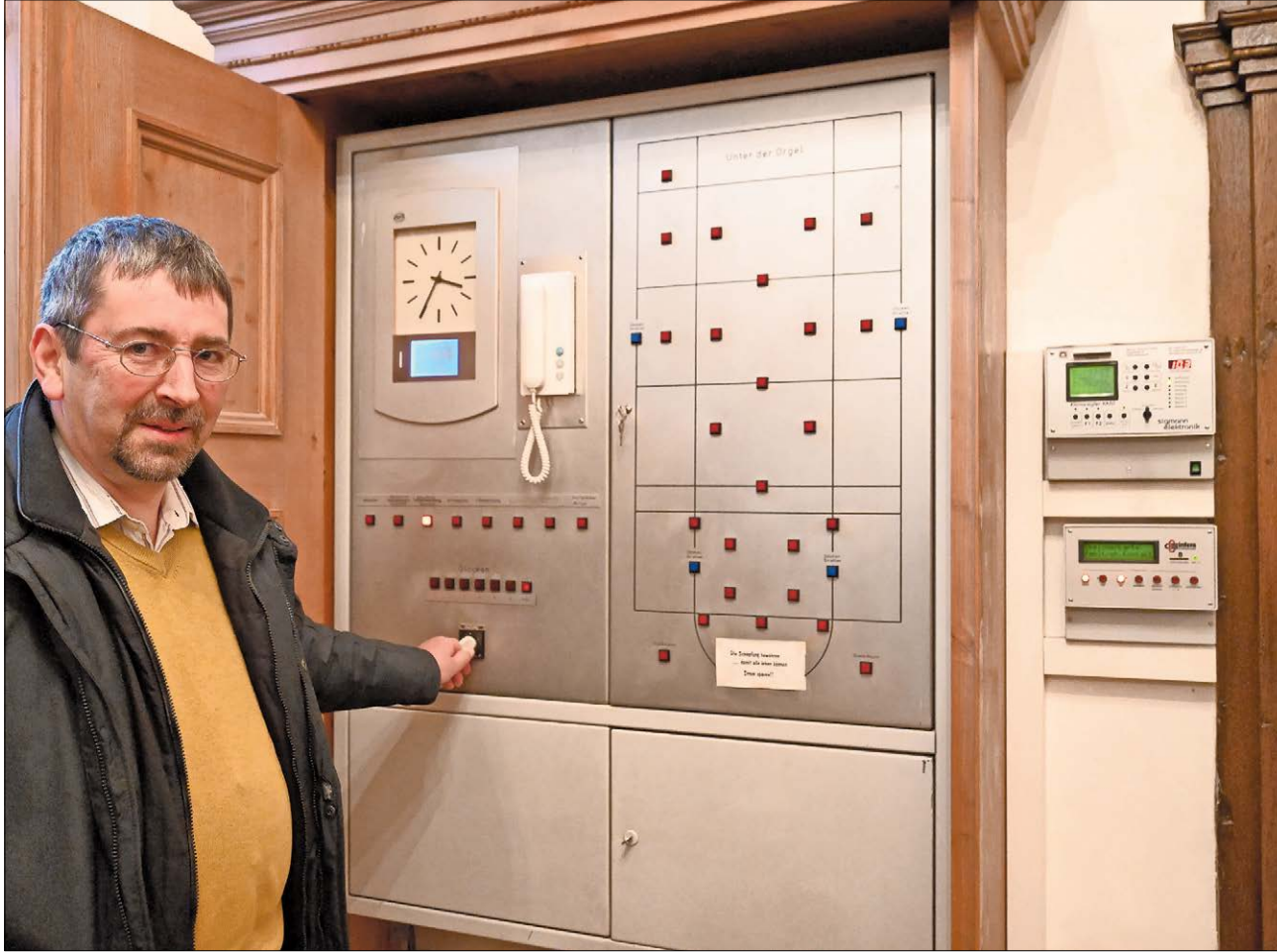
▲ Mesner Klaus Probst steuert die Temperaturregelung in der Basilika St. Peter in Dillingen an der Donau.
