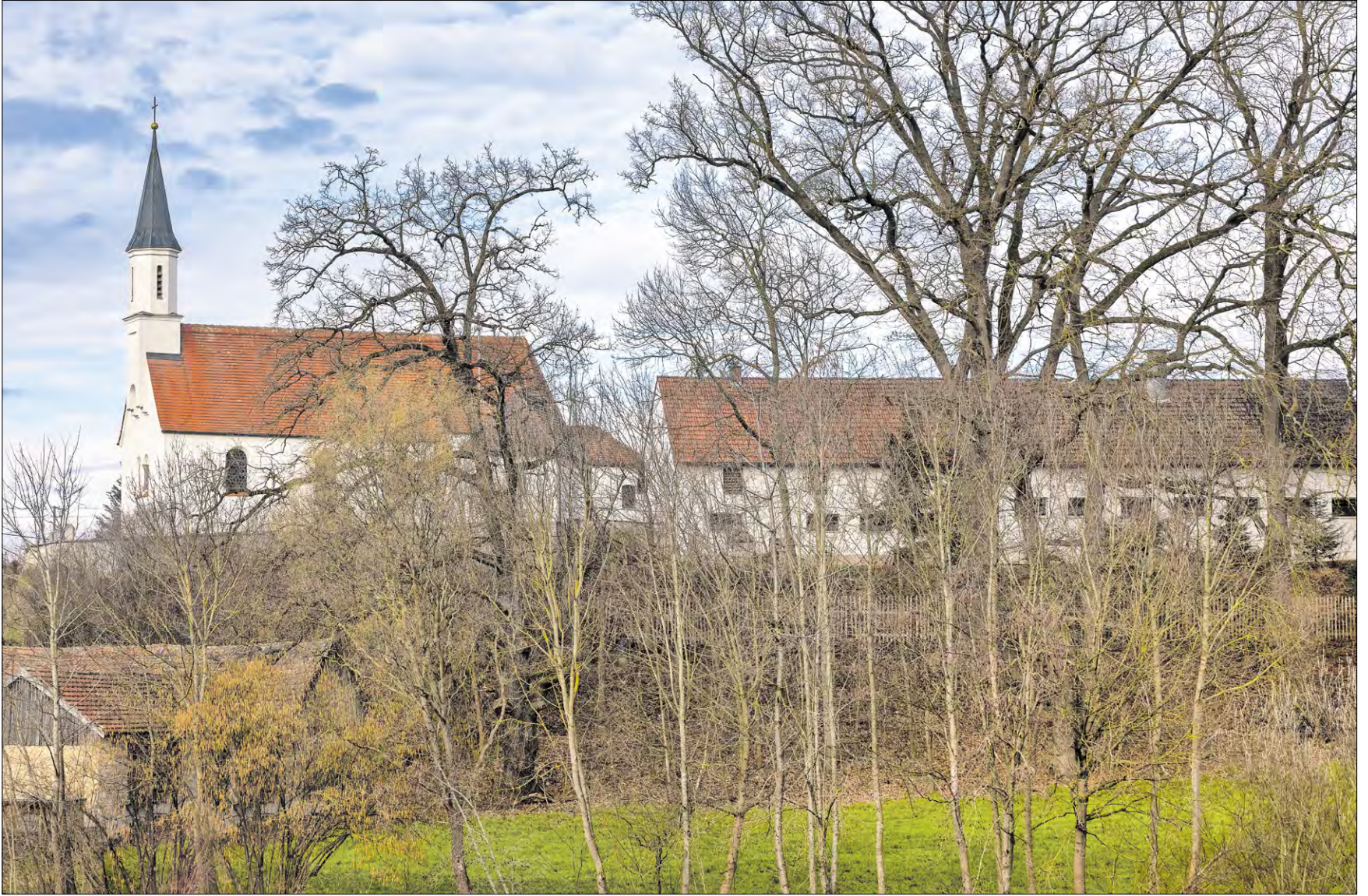
▲ Die Grundmauern der Kirche St. Stephan in Wiffertshausen – eine Filialkirche der Friedberger Pfarrei St. Jakob – gehen auf die Zeit vor 900 zurück. Bei Renovierungsarbeiten in den 1980er Jahren wurden die Grundmauern eines zweiten Baus um 1000 nach Christus nachgewiesen. Der Chorraum des heutigen Baus ist gotisch, vermutlich aus dem 15. Jahrhundert. Das Langhaus wurde im 18. Jahrhundert erneuert und die Kirche barockisiert. 1868 wurde St. Stephan nach Westen hin verlängert und ein Dachreiter ergänzt.
