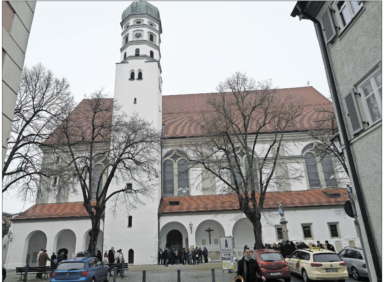
▲ Nach Abschluss der Renovierungsarbeiten hat die Stadtpfarrkirche und Konkathedrale des Bistums ein saniertes Dach. An Turm und Kirchengebäude wurden Maßnahmen zur Standsicherheit durchgeführt.
