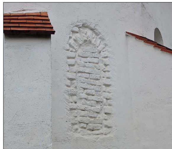
▲ Unter anderem zeigen freigelegte Reste mehrerer Fensteröffnungen den spätmittelalterlichen Kernbestand der Kirche. Foto: Mohr
