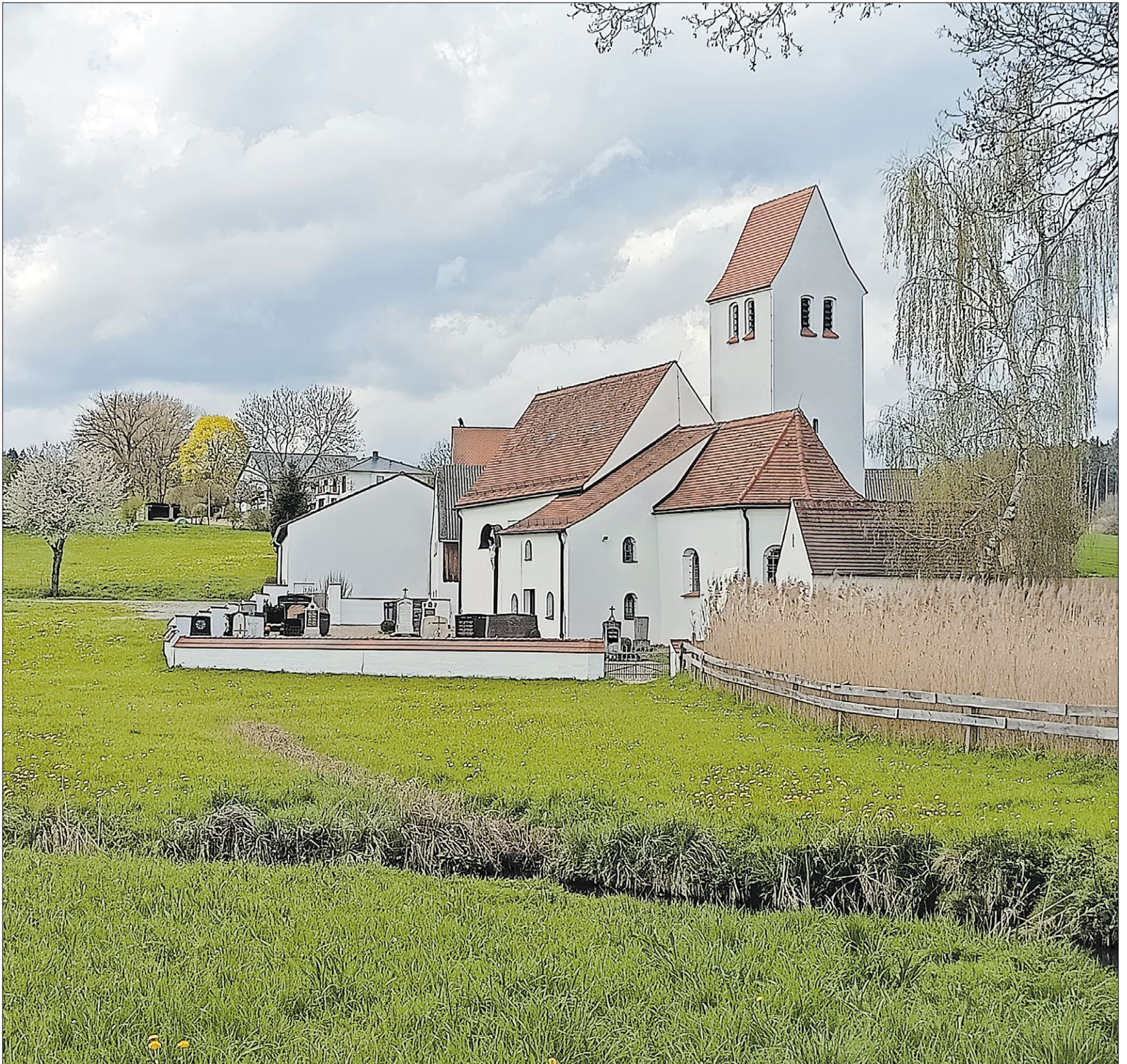
▲ Die Johannes dem Täufer geweihte Kirche im Schiltberger Ortsteil Aufhausen erstrahlt im neuen Glanz. Rund ein Jahr lang wurde die Kirche innen und außen saniert, wobei insbesondere der Glockenturm aufwändig erneuert wurde. Zur Pfarrei gehören die kleinen Dörfer Aufhausen und Bergen mit insgesamt nur 52 Einwohnern. Foto: Beck
