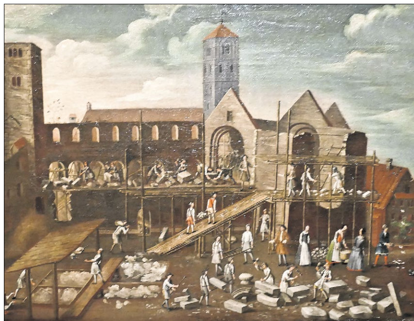
▲ Auf der Baustelle des Lindauer Damenstifts wird kräftig gearbeitet. Ölbild von 1748. Fotos: Paulus
