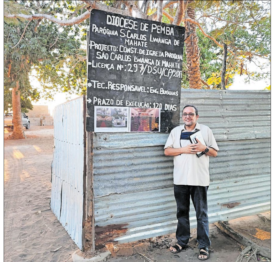
▲ Eduardo Andrés Roca Oliver, Leiter des interreligiösen Zentrums in Pemba, vor der Baustelle der Kirche „St. Karl Lwanga“.
