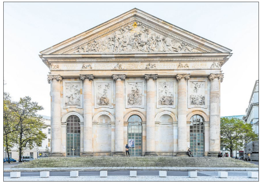
▲ Die Kathedrale Sankt Hedwig am Bebelplatz in Berlin-Mitte. Die historisch bedeutende Bischofskirche ist seit 2018 wegen umfassender Sanierungs- und Umbaumaßnahmen geschlossen. Die Wiedereröffnung ist für 2024 geplant.
