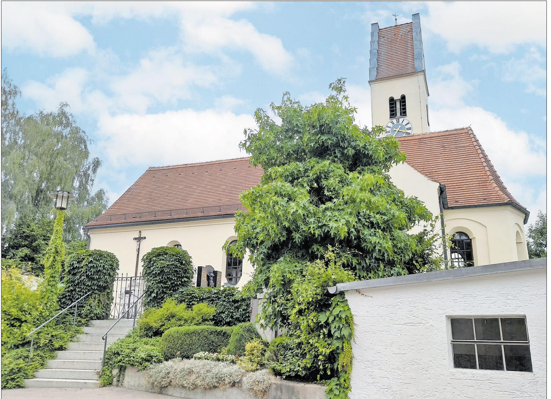
▲ Die Kirche St. Peter und Paul liegt – vom Friedhof umgeben – auf einem Hügel im Dorf Randelsried, einem Ortsteil von Altomünster im Landkreis Dachau. Der Ort an der Bistumsgrenze wird von der Pfarrei Schiltberg mitbetreut. Das heutige Gotteshaus besteht zu Teilen noch aus den Mauern einer früheren romanischen Kirche. Im 15. Jahrhundert wurde der Bau vergrößert und im Jahr 1843 umgebaut. Der Turm wurde 1886 erneuert. Foto: Beck
