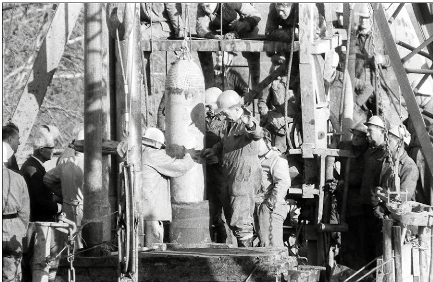
▲ Bergleute lassen am 7. November 1963 die Dahlbusch-Bombe, eine Rettungskapsel, in das Bohrloch, um damit die eingeschlossenen Bergleute zu bergen.
