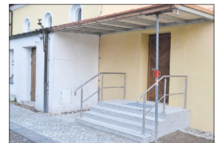
▲ Der neue Eingang an der Nordseite und die neue Toilette (links). Foto: Jäger
