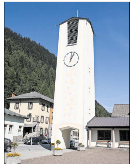
▲ Der Glockenturm der in den 1960er Jahren fertiggestellten Kirche Maria am Wege im Dorf Brenner. Der letzte eigene Pfarrer verließ das Dorf 1997.
