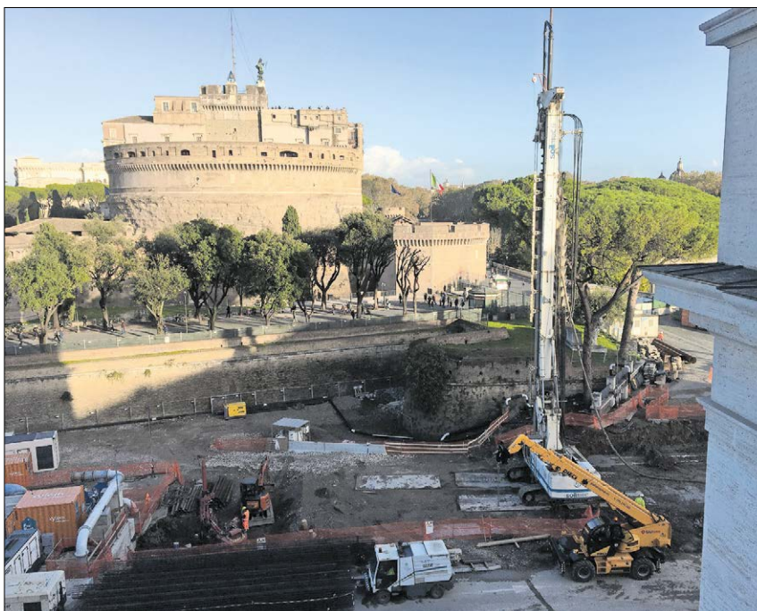
▲ Der Verkehr soll an der Piazza Pia nahe der Engelsburg im Heiligen Jahr durch einen Tunnel geführt werden: Die Bauarbeiten dafür sind in vollem Gange. Foto: Galgano
