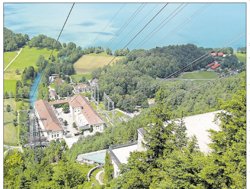
▲ Das Walchenseekraftwerk im oberbayerischen Altjoch bei Kochel am See. Vom Wasserschloss aus ist das Turbinenhaus und das Schalthaus zu sehen, hinten der Kochelsee.
