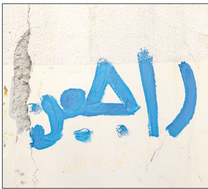
▲ „Wir kommen wieder“, hatten Islamisten an die Wand der Kirche Heiliger Georg geschrieben. Seit dem Wiederaufbau ist die Drohung nicht mehr zu sehen.
