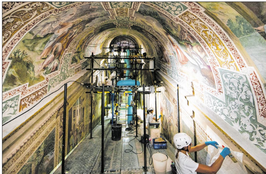
▲ Die Fresken an den Wänden der Heiligen Stiege werden umfassend restauriert.
