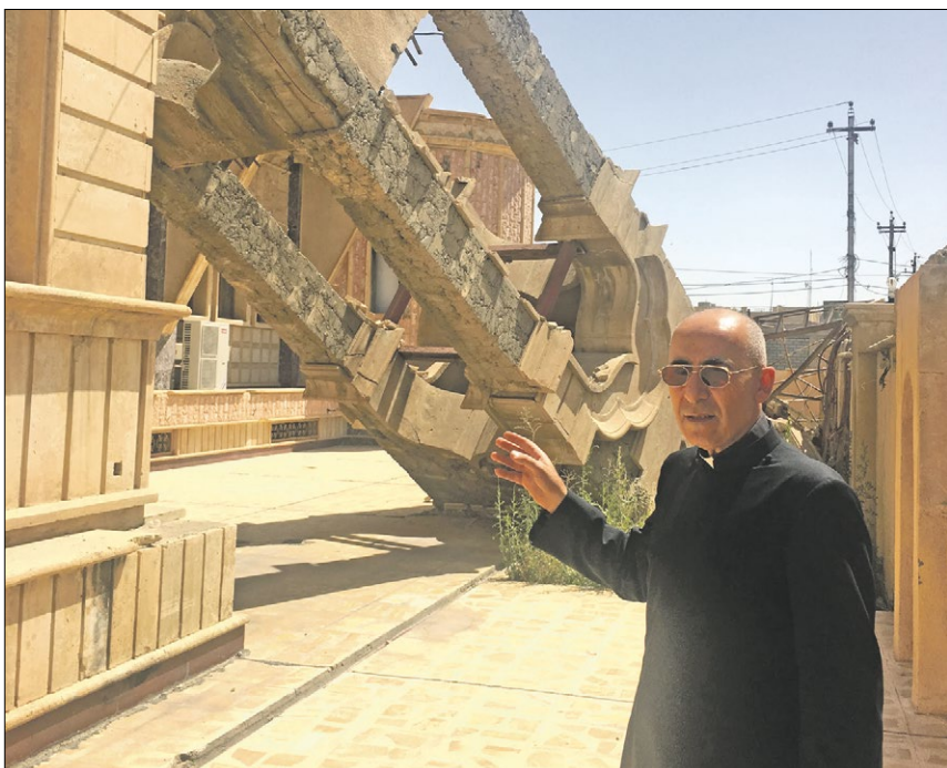
▲ Pfarrer Georges Jahola beklagt nicht nur die Zerstörung privaten Wohneigentums durch den IS. An der katholischen Kirche brachten die Islam-Terroristen den Glockenturm zum Einsturz. Fotos: Kirche in Not/Maksan
