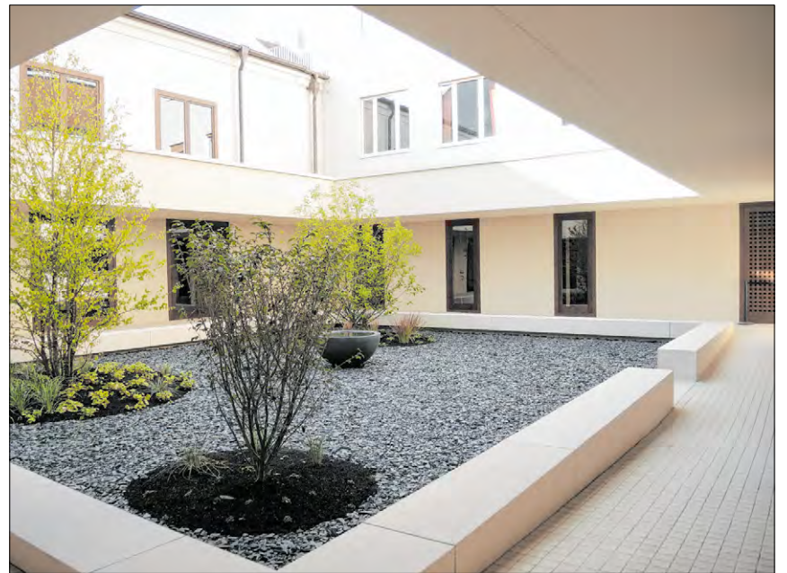
▲ Der neue Innenhof besticht durch seine strenge, einfache Gestaltung, die eine meditative Ausstrahlung vermittelt. In der Mitte steht ein Brunnen, in dem sich die Oberfläche des Wassers leise kräuselt. Fotos: Mitulla (4)
