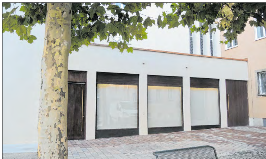
▲ Großzügige Fenster und Türen wurden im Rahmen der Umbau-Arbeiten zum Moritzplatz hin eingebaut. Dahinter liegt der Raum für das „Offene Ohr“.
