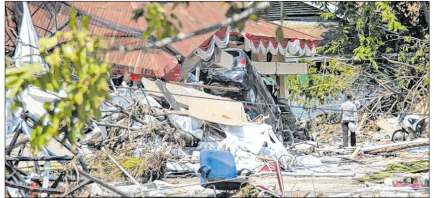
▲ Erdbeben und ein Tsunami haben schwere Schäden hinterlassen. Foto: ADH
