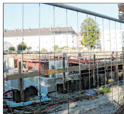
▲ Zwei Häuser sind fertiggestellt, vier weitere Trakte werden gebaut.
