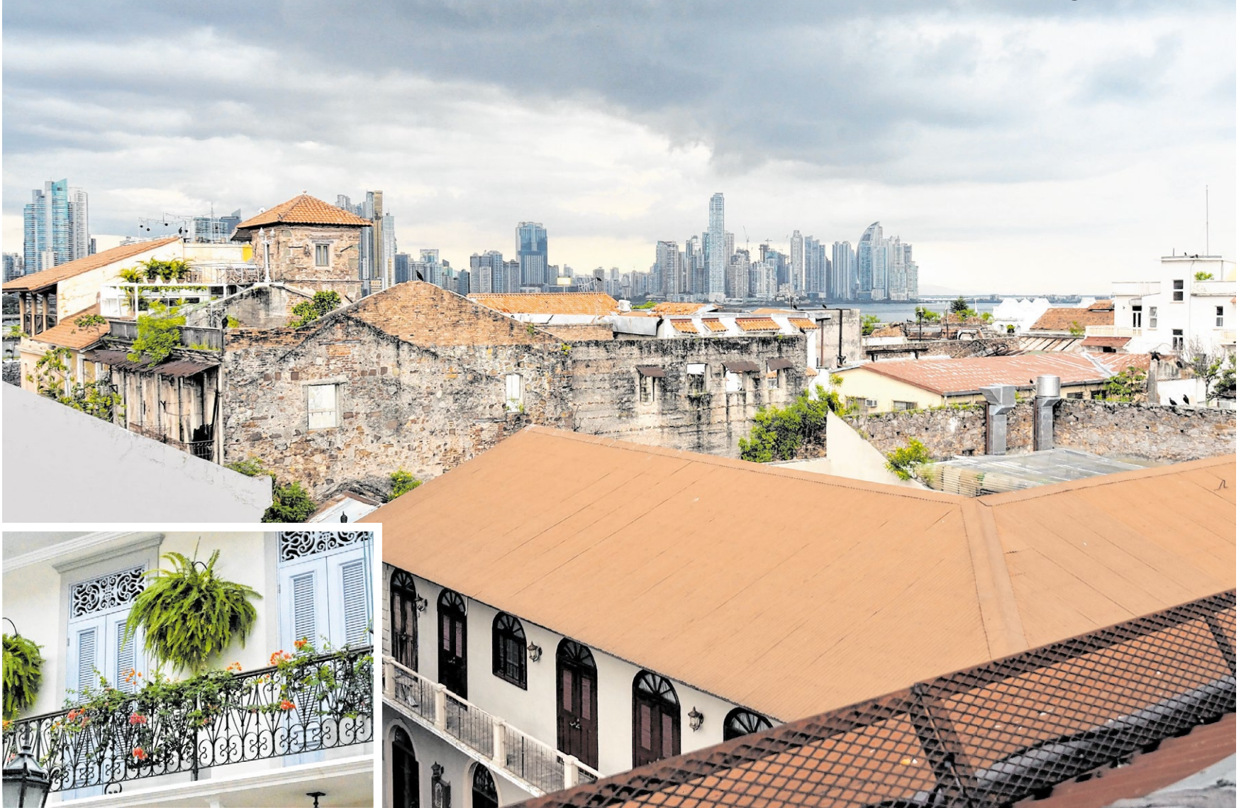
▲ Der Blick über die Dächer der Altstadt lässt in der Ferne die modernen Hochhäuser von Panama-Stadt erkennen. Während einige Gebäude heruntergekommen sind, wurden andere liebevoll saniert, wie die Balkone beweisen (kleines Foto). Fotos: Drouve
