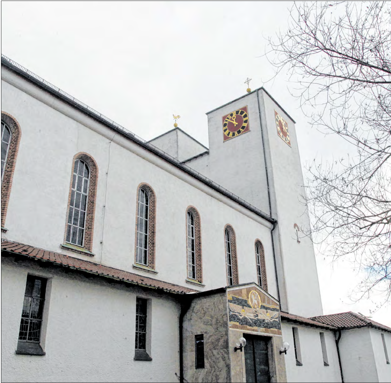
▲ Die Pfarrkirche St. Martin in Augsburg-Oberhausen liegt im Norden des Stadtteils. Die dreischiffige Basilika mit eingezogenem Chor ist als Baudenkmal geschützt. Das Pfarrheim wurde 2018 abgerissen. Dort steht nun der Neubau des St.-Vinzenz-Hospizes. Seit November 2015 ist die Kirche St. Martin eine Station auf dem Via Sancti Martini zu Ehren Martin von Tours. Oberhausen wuchs in der industriellen Revolution um 1920 weiter nach Norden, auch die Pfarrei St. Peter und Paul, so dass der Bau einer zusätzlichen Kirche erforderlich wurde. Am 21. Mai 1933 erhielt die Expositur St. Martin eine hölzerne Notkirche. Die Grundsteinlegung für die heutige Kirche erfolgte nach Plänen des Augsburger Architekten Fritz Kempf am 17. September 1933, die Weihe durch Bischof Joseph Kumpfmüller am 15. Juli 1934. Foto: Zoepf
