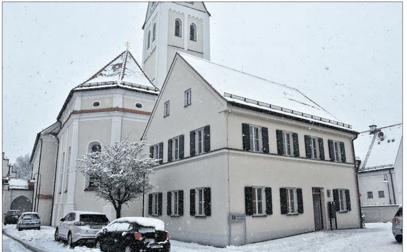
▲ In der Farbgebung wurde das renovierte Benefiziatenhaus auf die Pfarrkirche abgestimmt. Dadurch wurde das Ensemble, das die beiden Gebäude in Hohenwart bilden, unterstrichen. Fotos: Hammerl (4)
