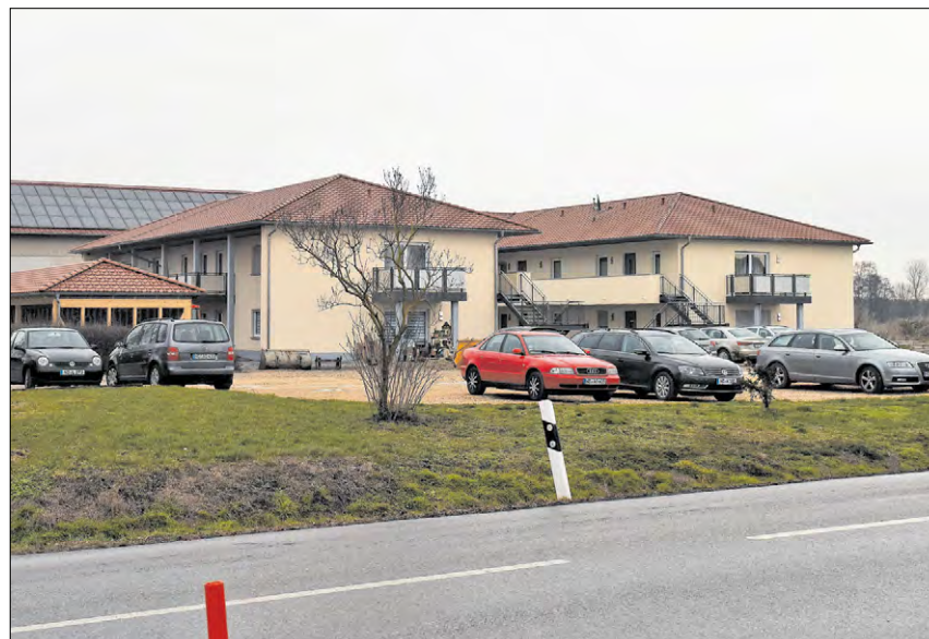
▲ Die Außenanlagen müssen noch fertiggestellt werden, innen aber ist das Mehrgenerationenhaus fertig. Die meisten Mieter sind bereits eingezogen.
